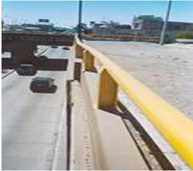
Paso a desnivel, Calle Álvaro Obregón
