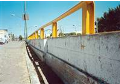
Paso a desnivel, Calle Álvaro Obregón, con vías del ferrocarril
