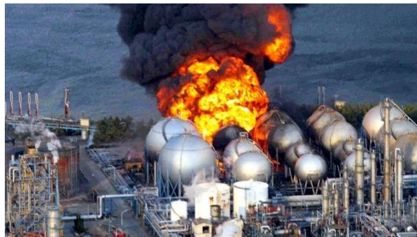
Fig. 36. Explosión tipo BLEVE.
