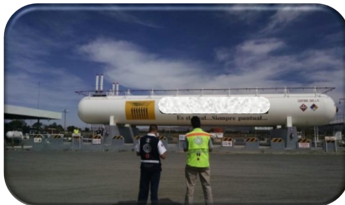
Fig. 47. Inspección de identificación y análisis de peligros y riesgos de sustancias químicas. Tanques de almacenamiento de Gas L.P. en el municipio de Silao.
