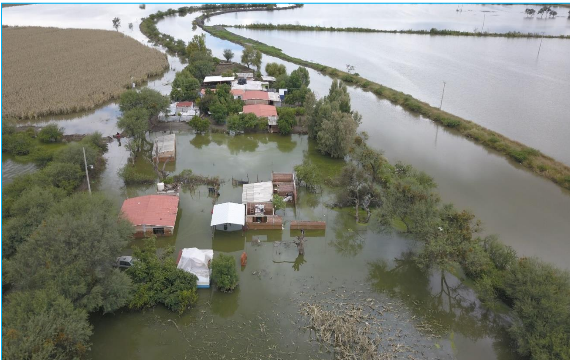
Ilustración 2. Inundación Fluvial en el municipio de Abasolo, septiembre 2021.
